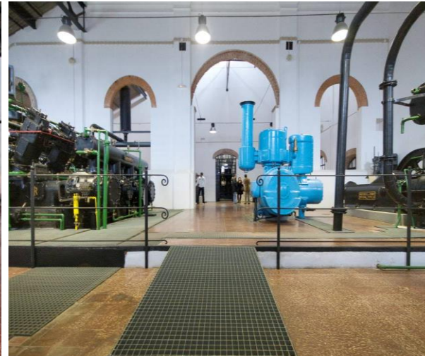
Geradores de ar comprimido
