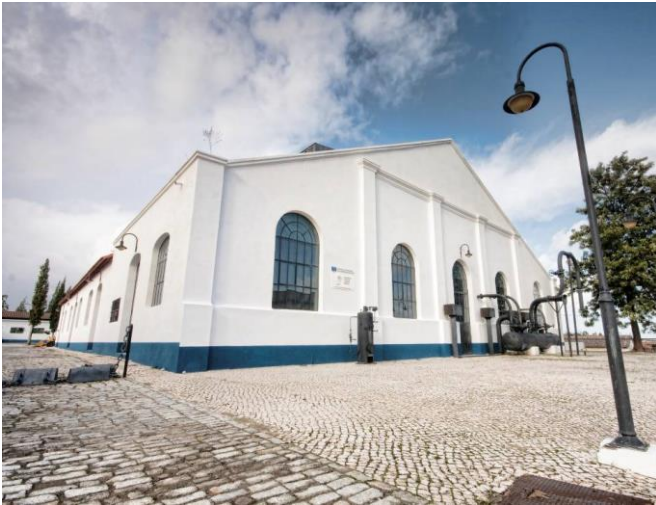
Antiga central eléctrica
